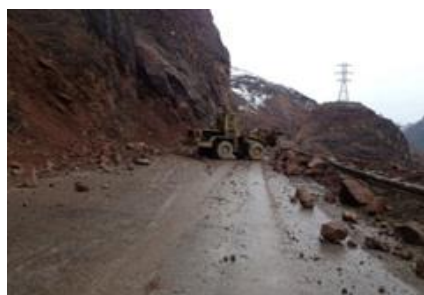
Участок камнепадов, 400-й км дороги БО (строительство туннеля длиной 740 м)
