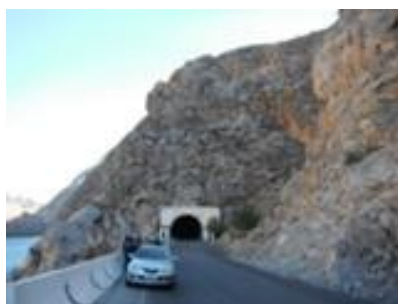
Участок камнепадов, 409-й км дороги БО (установка защитных сеток)
