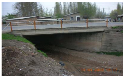
Мост на обозначенном участке дороги ОБИ
