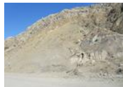
Участок оползней на 451-м км дороги БО (установка свай)
