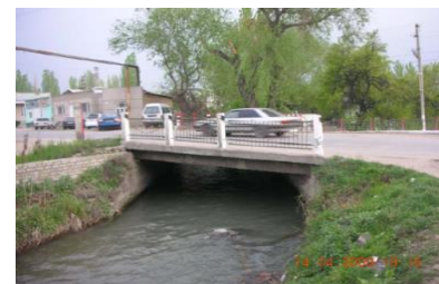
Мост на обозначенном участке дороги ОБИ
